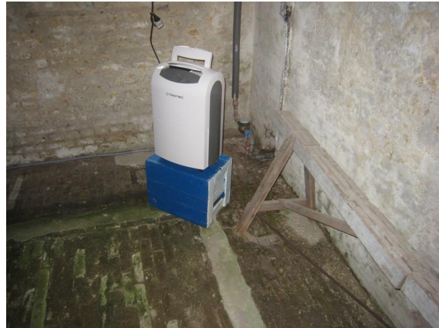
I kælderrum kan anvendes en mekanisk affugter til regulering af luftfugtigheden.
