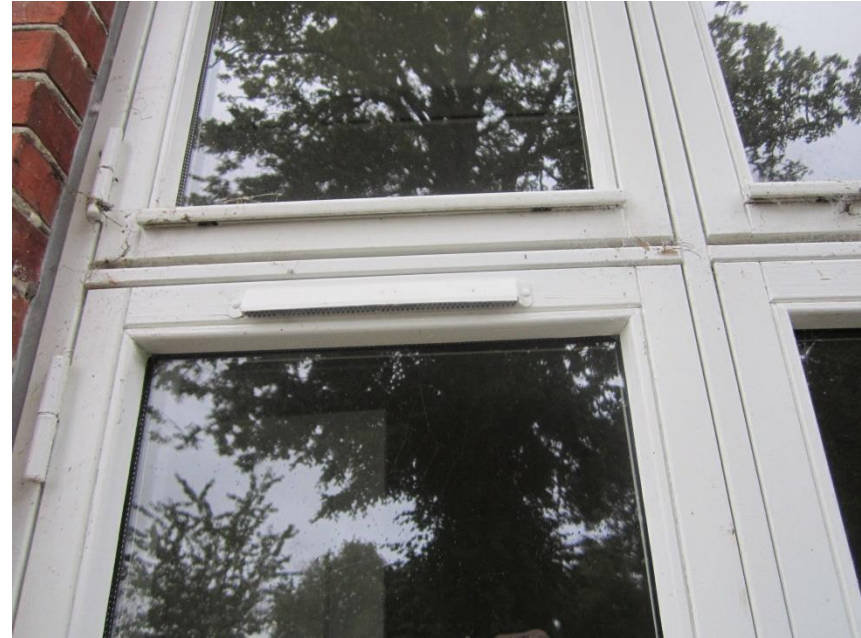
Ventiler i vinduerne sikrer en lille konstant tilførsel af udeluft til boligen.
